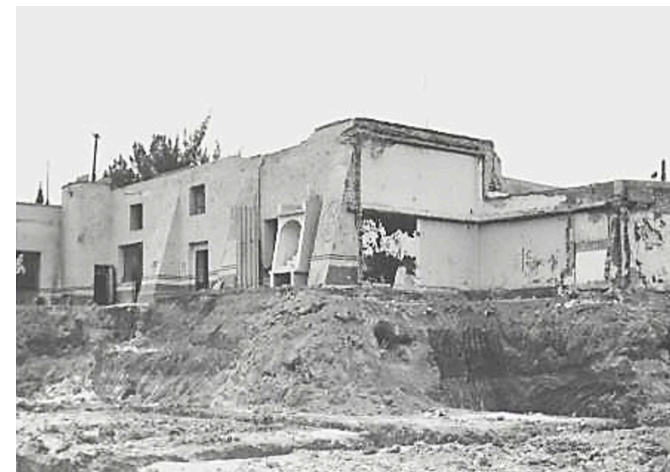
Foto de la capilla de La Santa Cruz, vista desde la parte posterior, en el momento en que se estaba construyendo el nuevo Palacio Municipal. Hacia el lado derecho se observan tres contrafuertes en el muro norte, y la pequeña torre del antiguo campanario. En el interior de ésta se conserva la escalinata de caracol. Como se mencionó, la capilla se conservó como monumento histórico y actualmente allí está instalada la Oficialía del Registro Civil.
