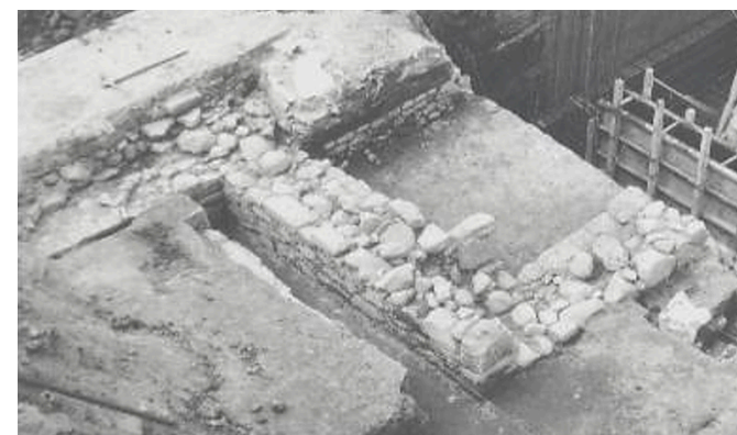
Vista de un cimiento de piedra localizado en la parte posterior de la capilla de La Santa Cruz, durante las obras de construcción del nuevo Palacio Municipal de Tultitlán. Dicho cimiento debe corresponder con los cuartos señalados en el croquis adjuntado en el acta de cabildo del tres de marzo de 1878.
