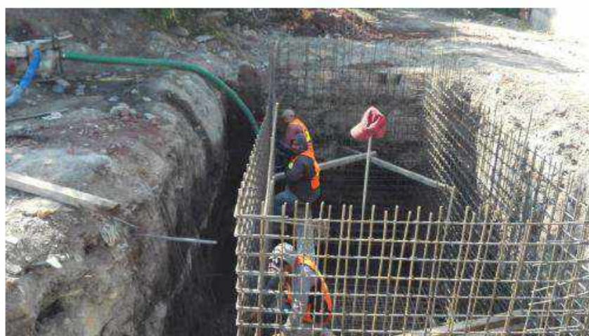
Construcción de cárcamo en colonia Zona Industrial Lechería Cuautitlán
