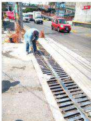
Personal de APAST coloca boca de tormenta en Av. José López Portillo, colonia RIMESA El Paraje
