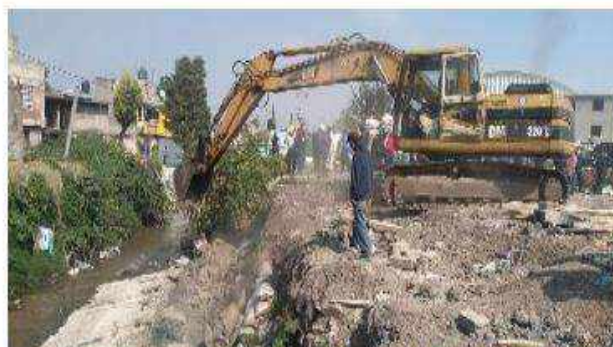
Liberación de área de restricción, Canal de las Cruces, Colonia Independencia
