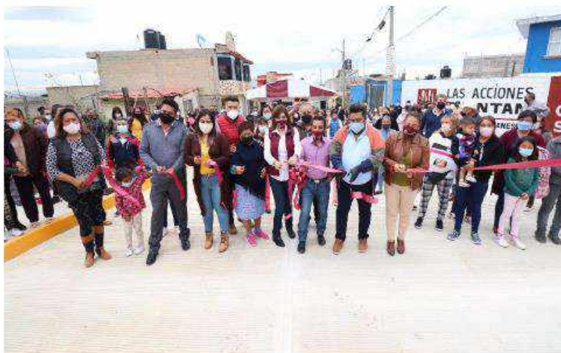
Inauguración de pavimentación con concreto hidráulico Calle Monte Calvario, Pueblo de San Mateo Cuautepéc, inversión $ 3,589,705.23
