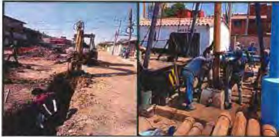
A la izquierda, personal de APAST realiza trabajos de construcción de línea de conducción de agua potable y a la derecha desinstalación de equipos de bombeo, 2023.
