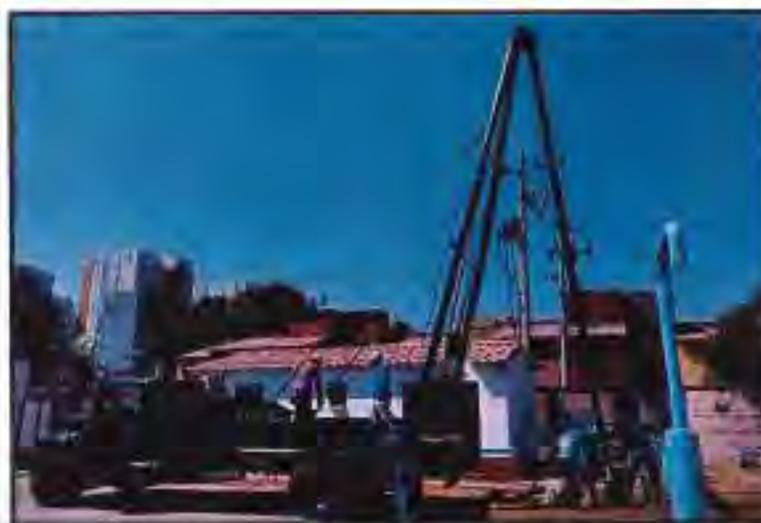
Personal de APAST, realiza trabajos de instalación Bomba sumergible de 150 HP, zona centro, 2023.
