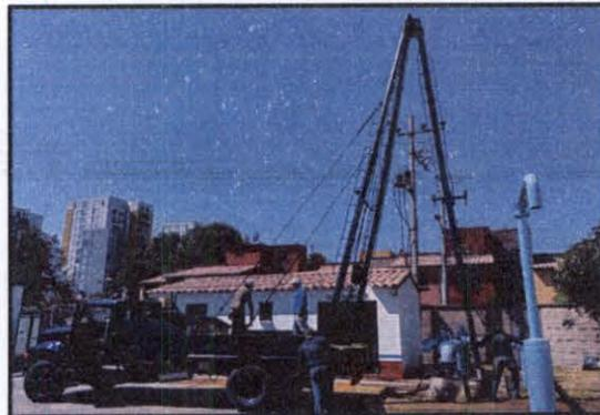
Personal de APAST, realiza trabajos de instalación Bomba sumergible de 150 HP, zona centro, 2023.
