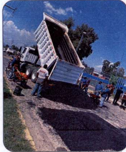
Trabajos de Bacheo en Avenida Las Torres, entre Blvd. Tultitlán y Vía José López Portillo.
