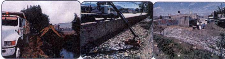
De izquierda a derecha, trabajos de azolve por parte de personal del OPD APAST en canales de aguas residuales "Lechería-Cartagena", "Buenavista", "Las Cruces", año 2022.
