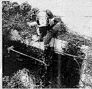
Personal de AFAST realiza trabajos de mantenimiento en cárcamo zona Centro
