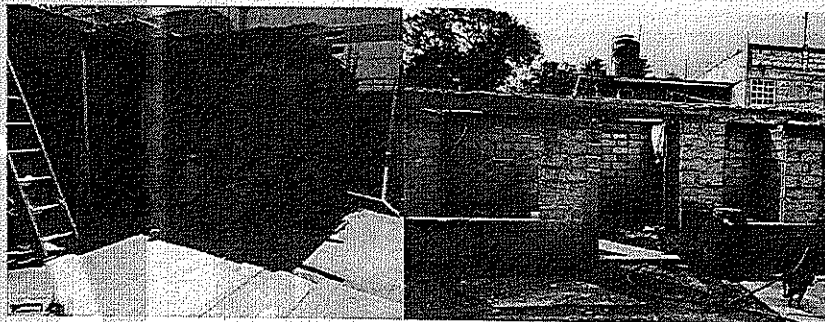
Viviendas censadas por la Coordinación de Bienestar para la construcción de cuarto dormitorio y techo firme.
