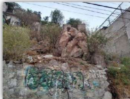
Foto 12. Alto fracturamiento sobre un caído de roca, siendo una amenaza para la población. #356 Santa Barbara, San Marcos Buenavista, Tultitlán, Edo. De México.
