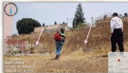
Foto 8. En esta pequeña ladera la pendiente es de 30 ° aproximadamente, constituida por limo y arena, en temporada de lluvia se puede convertir en un flujo de tierra, Tulipanes Buenavista, Tultitlán Edo. De México
