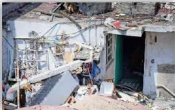
Imagen 31. Explosión de tanque de gas en vivienda.
