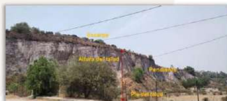
Foto 5. Descripción de los componentes de una ladera natural. Santa María Cuauhtepac, Tultitlán, Edo de México
