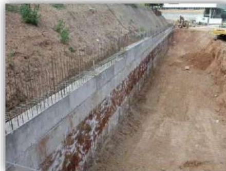
Foto 4. Ejemplo de un muro de contención en una ladera inestable, cuya pendiente es muy inclinada
