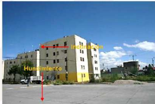
Imagen 22. Inclinación de edificios por hundimiento por explotación de acuíferos. Jardines de San Pablo, en San Pablo de las Salinas. Actualmente el edificio los desalojó INFONAVIT por el riesgo que implica habitarlos
