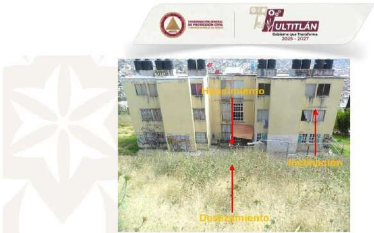
Imagen 24. Amenaza de deslizamiento de tierra y derrumbes en terrenos afectados por la Falla La Quebrada, Colonia Tulipanes FUENTE: ACTUALIZACIÓN DEL ATLAS DE RIESGOS DEL MUNICIPIO DE TULTITLÁN, ESTADO DE MÉXICO.
