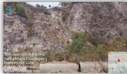
Foto 14. Volteos de roca con giro hacia adelante debido al alto fracturamiento en la zona. Juan de la Barrera, Santa María Cuauhtepac. Fuentes del Valle, Tultitlán, Edo. De México.
