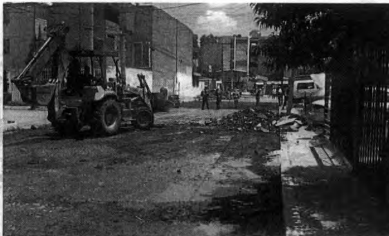
Personal de la Dirección de Servicios Públicos en trabajos de Bacheo en Fraccionamiento Fuentes del Valle
