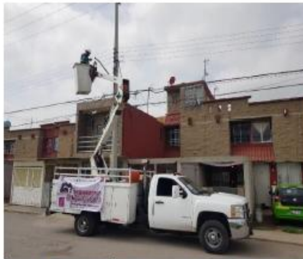
Mantenimiento y reparación de luminarias en comunidades de Tultitlán Dirección de Servicios Públicos
