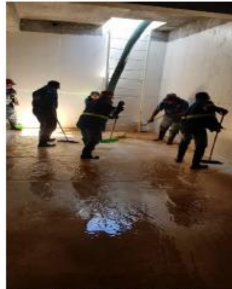
Personal de APAST realiza lavado de Cisterna en Colegio de Bachilleres del Edomex, Plantel 25
