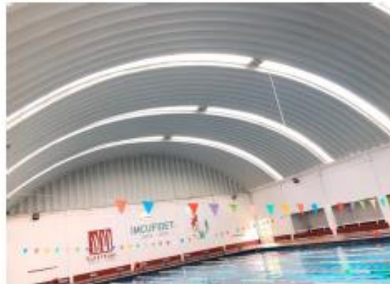
Renovación de láminas en área de alberca Deportivo El Reloj
