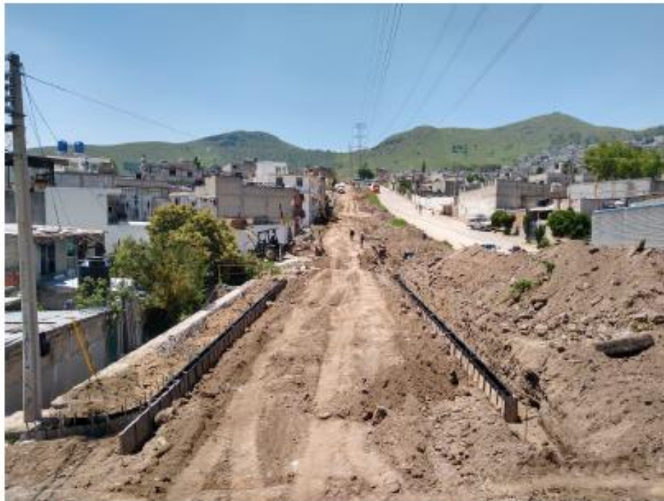
Liberación de vía, construcción de guarniciones y banquetas de la Avenida Rosario Ibarra de Piedra, Tultitlán Zona Sur, 2020.
