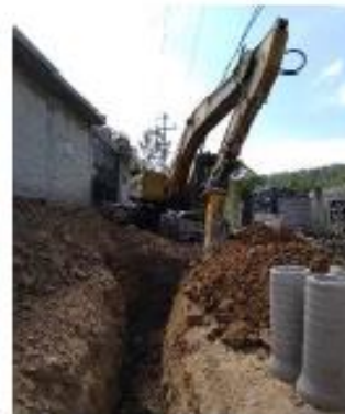
Construcción de Muro de Mampostería, calle Margarita Maza de Juárez Pueblo de San Francisco, Chilpan
