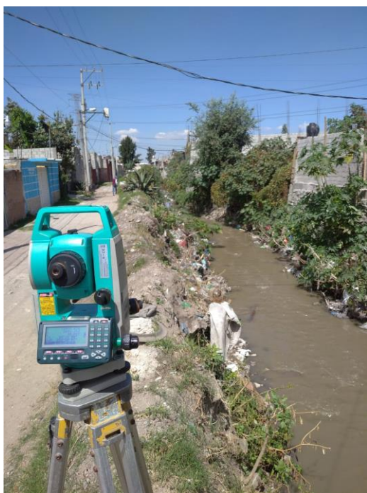
Trabajos de ingeniería civil e hidráulica en canal "Las Cruces", colonia La Libertad, zona Sur
