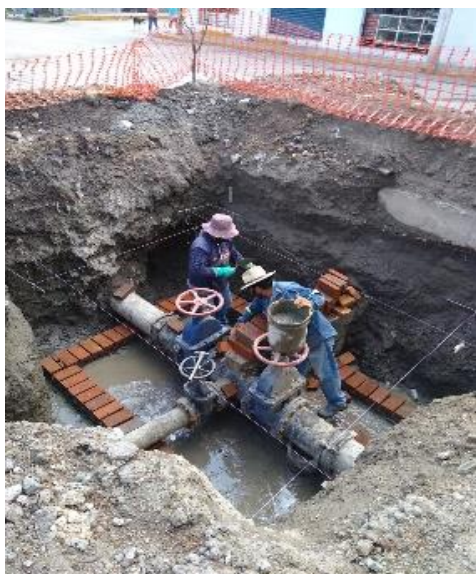
Interconexión de Línea de agua potable Av. Estado de México, Col. Las Torres 1ª
