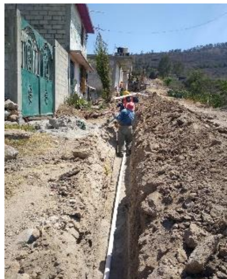
Red de agua potable, calle Huixquilucan, Col. Solidaridad 3ª Sección
