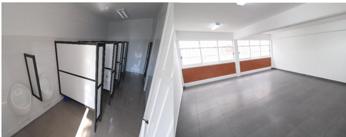
Rehabilitación de sanitarios Construcción de aula
