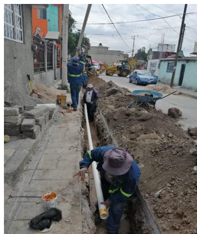
Personal de APAST introduce Red Hidráulica en Av. El Sabino y calle Mariscal en Barrio Santiaguito y Pueblo de Santa María Cuauhtepac
