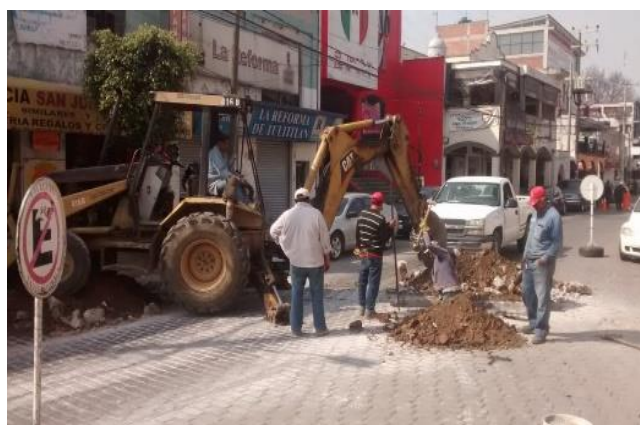
Personal de APAST realiza trabajos de desazolve de fosa séptica y conexión de drenaje en comunidades de Tultitlán
