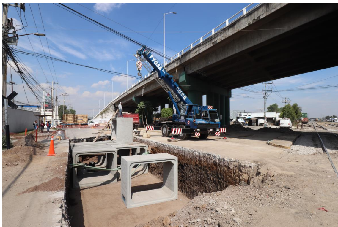
Obras de ampliación de drenaje (Encajonamiento) sobre Boulevard Tultitlán, Colonia Los Reyes, inversión: $22, 500,000.00
