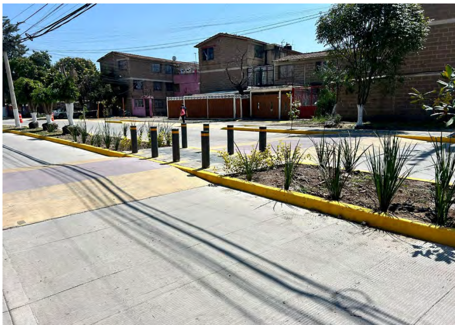
Pavimentación y obras complementarias en Avenida Rancho San José, Fraccionamiento Villas de San José, año 2024
