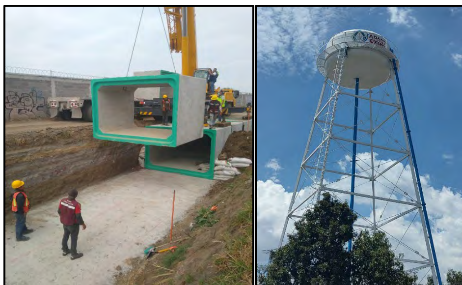
Personal de APAST, realiza Colocación de cajón de concreto reforzado y trabajos de pintura y rotulación en el exterior del tanque.
