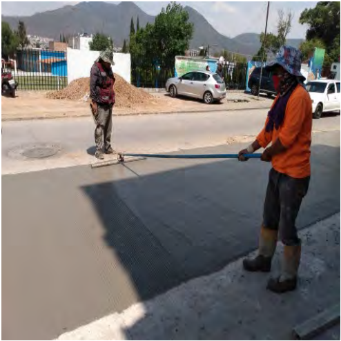
Trabajos de Bacheo con concreto hidráulico en Avenida Hermenegildo Galeana, Colonia Buenavista Parte Baja, año 2024.
