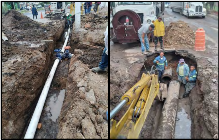
A la izquierda, el personal de APAST realiza mantenimiento y reparación de infraestructura hidráulica en Fracc. Villas de San José y a la derecha mantenimiento y reparación de infraestructura hidráulica en Zona Industrial Cartagena, 2024.
