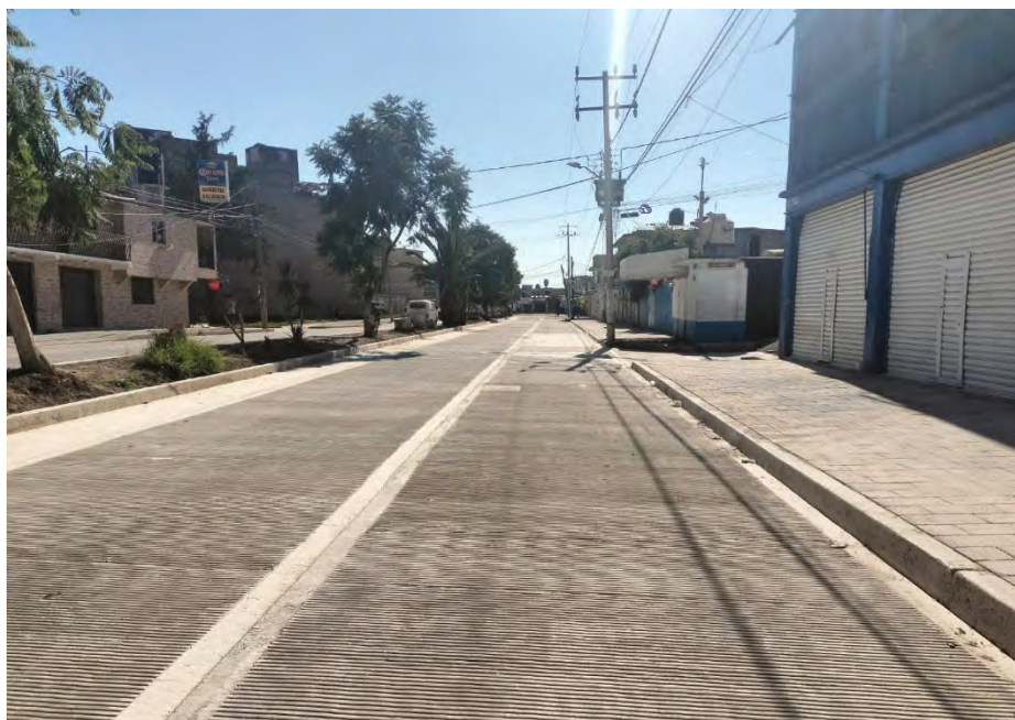
Pavimentación y obras complementarias de Avenida Prados Norte, Unidad Habitacional Morelos 3ª Sección, año 2024
