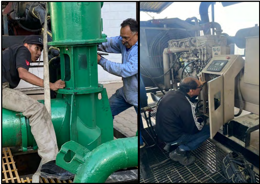
A la izquierda, personal de APAST realiza instalación de equipo de bombeo y motor rehabilitados y a la derecha mantenimiento a módulo de control de equipo de combustión interna, 2024.
