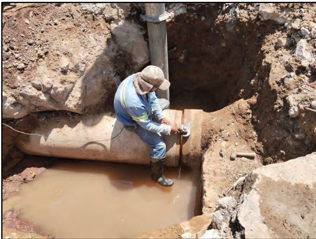
Personal de APAST repara tubería fracturada en Avenida Industrias, Fraccionamiento Izcalli del Valle, 2024.
