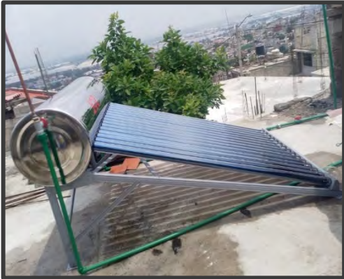
Calentadores solares instalados en viviendas de la Colonia La Libertad, Tultitlán, Estado de México, 2024.
