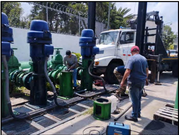
Personal de APAST realiza maniobras de instalación de equipos de bombeo rehabilitados, 2024
