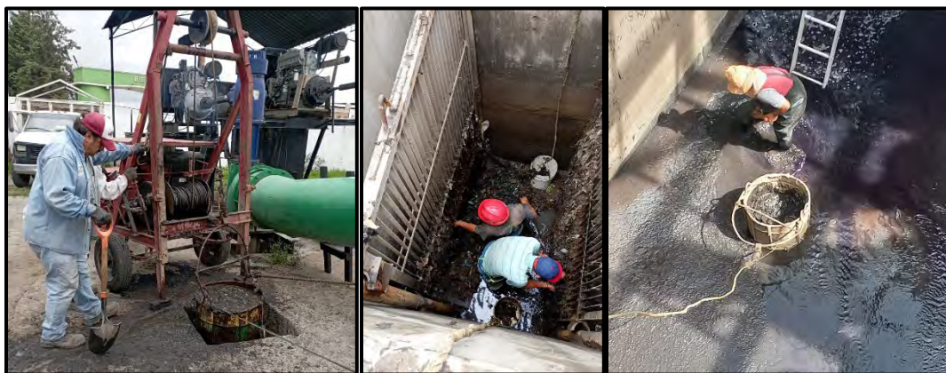
Personal de APAST realiza desazolve de Cárcamo Fuentes 1, Los Reyes y Cartagena, 2024.
