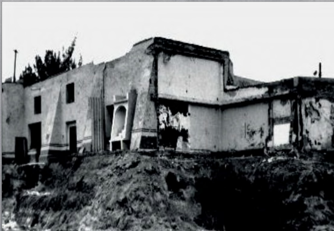
Vista posterior de la capilla de la Santa Cruz, durante los trabajos de construcción del nuevo palacio municipal de Tultitlán.
